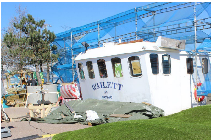
Styrhytten under byggfasen. Foto: Prototyp Göteborg
